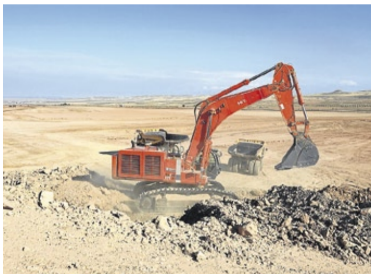
22-9-2019. La maquinaria se encarga de la explanación de los terrenos.
