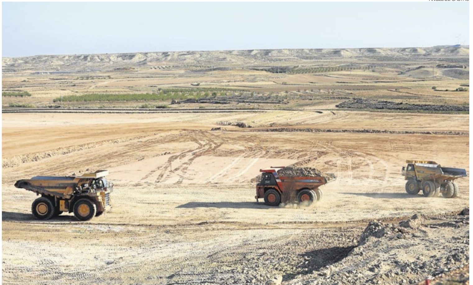
►► Grandes camiones cargados de tierra y piedras se encargan de la explanación de 180 hectáreas junto a la carretera de acceso a Épila desde la A-2.
