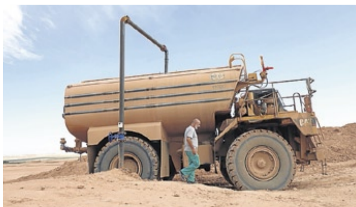
►► Cuba de 50.000 litros en los trabajos de explanación.
