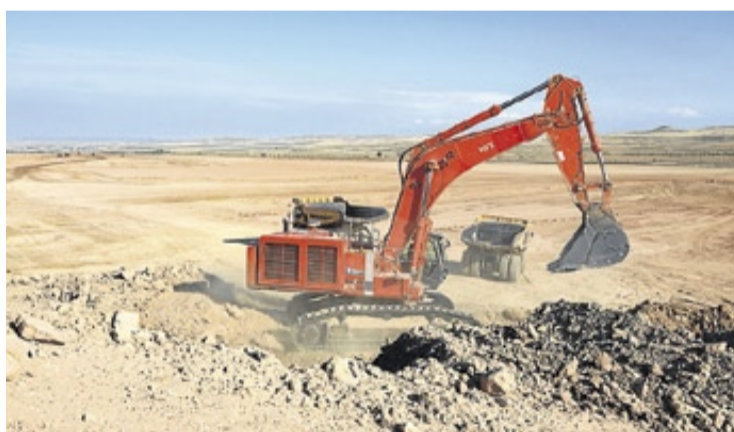
►► Una excavadora en las obras de preparación de los terrenos.
